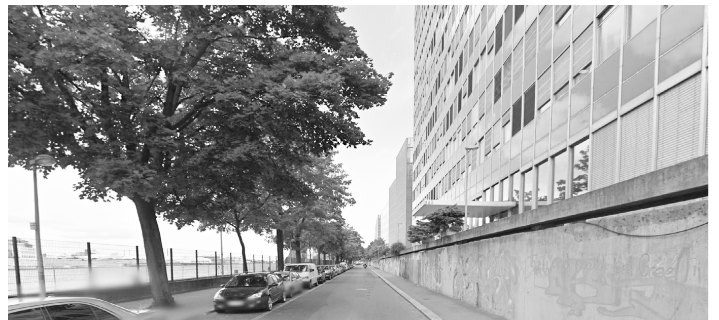
Blick Richtung Norden am unteren Rheinweg, (vor, unter und nach der Dreirosenbrücke) Quelle: Google Maps
