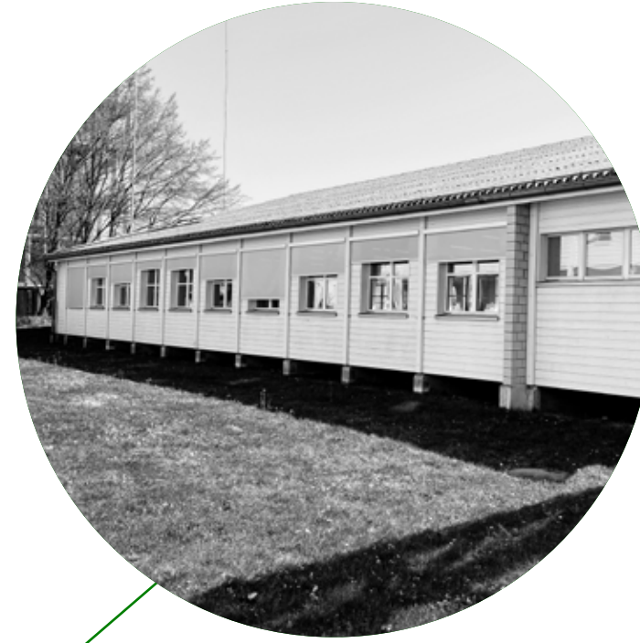
ETH PAVILLION Holzstütze 4m 69/69 Holzträger 7,5m - 4m 90/462
