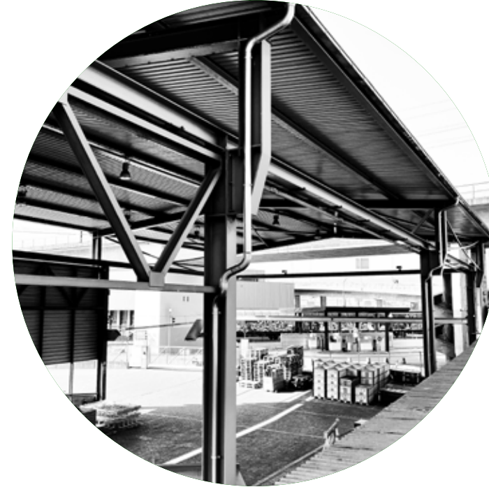
EWZ Stahlträger HEA 40 7m 10/18 Stütze 6m 12/12 Wellblech 0/22
