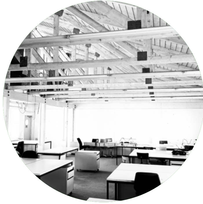
ETH PAVILLION Pavillionstrukturen gesamt. 4/6
