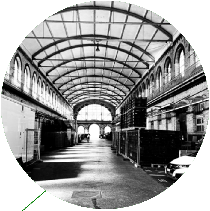
SCHWEINEHOF Stahl Rundbogen T Träger 15m 8/16 Stahl Hohlträger 5m 120/135
