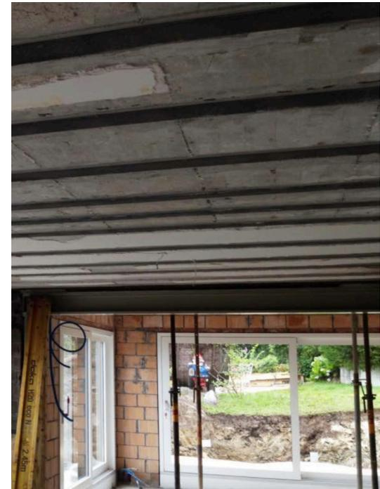
Karbonbänder zum Wände und Decken verstärken
