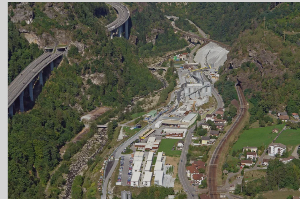
▲ Die Neat-Baustelle in Faido. Alptransit.ch
