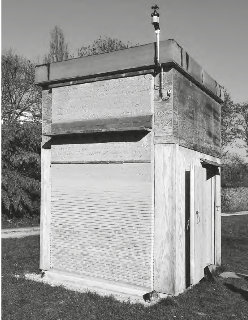
Mock-up Ozeanium Zoo Basel, Boltshauser Architekten AG: Das Speicherpotenzial der Lehmwände soll genutzt und erforscht werden. Eingelegte Leitungsregister in der Lehmfassade machen eine Kälte- und Wärmerückgewinnung möglich.
