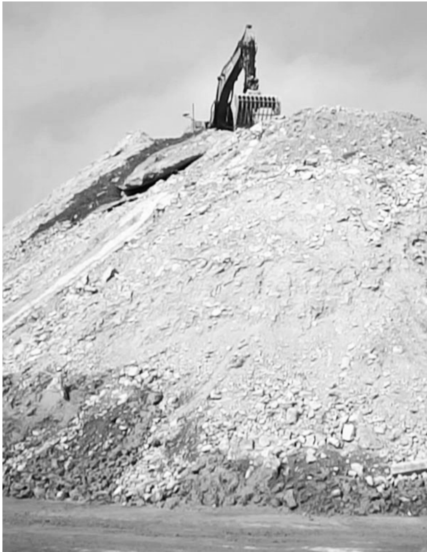
Aushubmaterial als ungenutzte Ressource (Quelle: Professur für Nachhaltiges Bauen, ETH Zürich)
