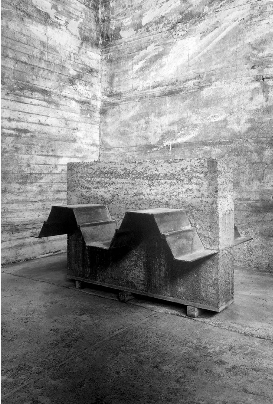
Links: Mock-up, hergestellt mit Studierenden während der Summer School 2017, Hybridkonstruktion mit recycelten Spundwänden aus Stahl, Studio Boltshauser
