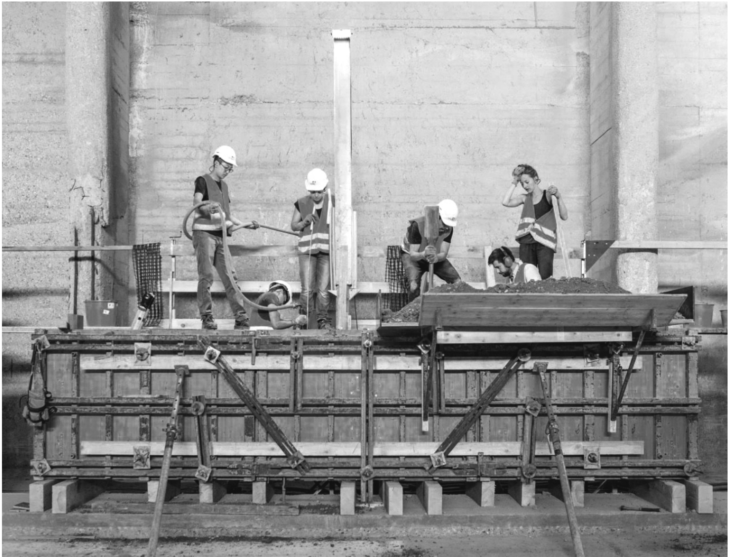
Produktion von Stampflehmeelementen für den Ofenturm in Cham. Summer School 2019 in Brunnen (Fotografie: Philip Heckhausen)
