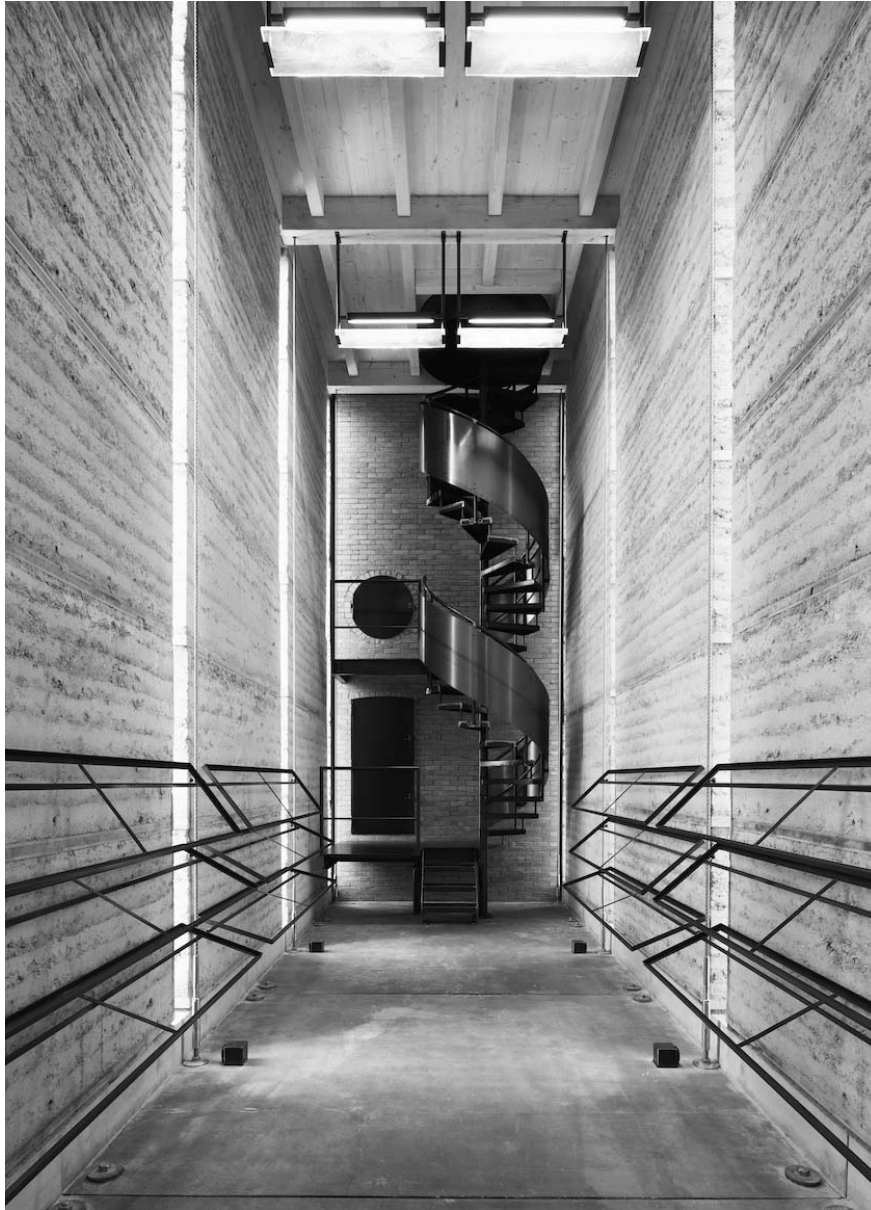
Ofenturm, Ziegelei-Museum Cham, Boltshauser Architekten AG (Fotografie: Sandro Livio Straube)
