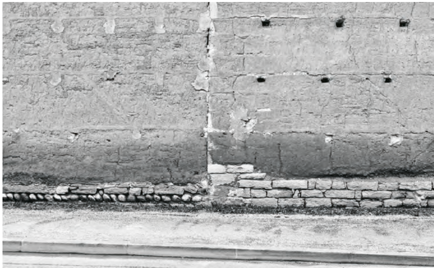
Ein grosser Dachüberstand sowie ein gemauerter Sockel schützen den Lehm vor Witterung. Scheune in Saint-Didier-d'Aussiat (Fotografien: Philip Heckhausen)
