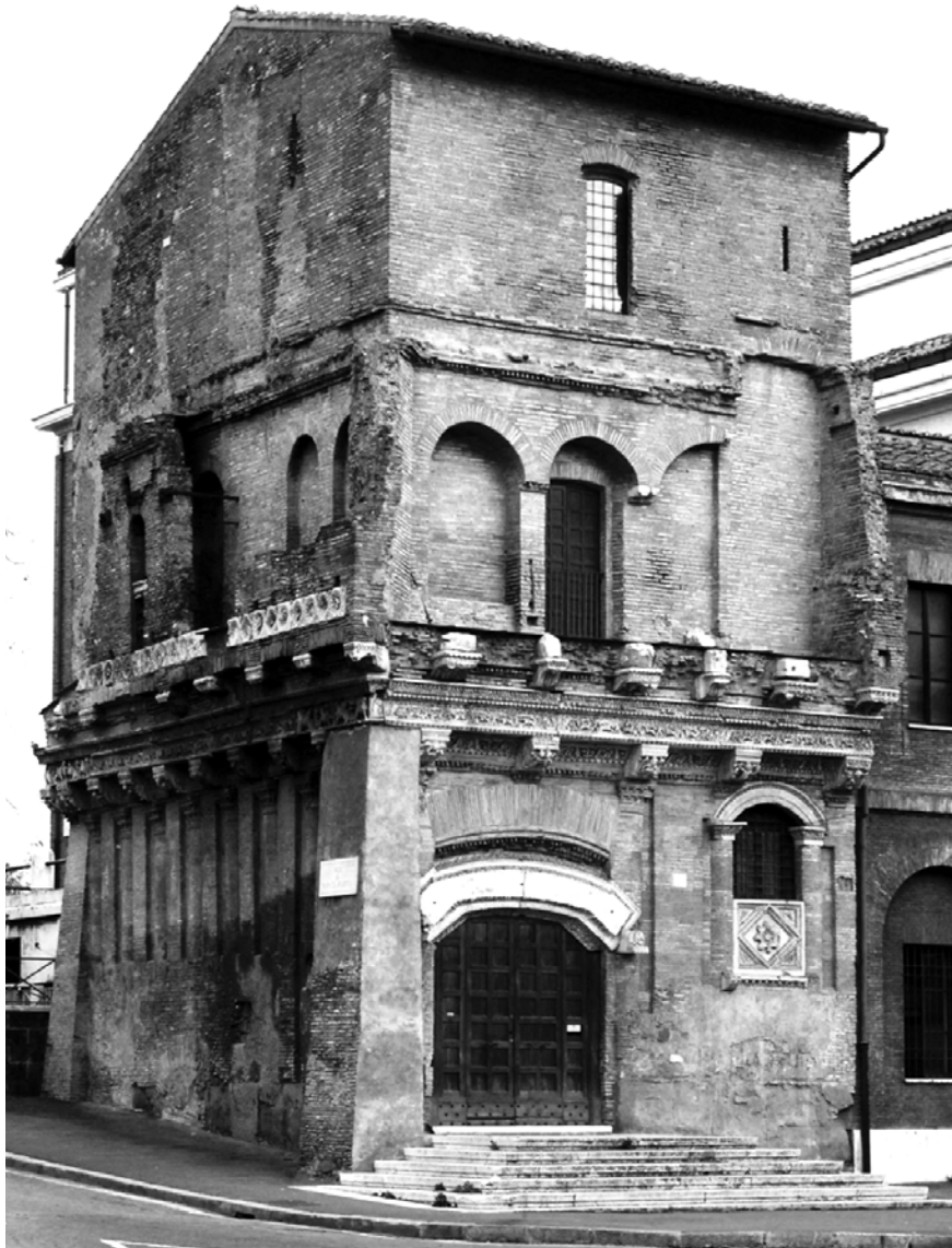
Wiederverwendung in der Geschichte: Die Casa dei Crescenzi wurde zwischen 1040 und 1065 von Nicolò di Crescenzio erbaut und ist damit das älteste noch erhaltene mittelalterliche Haus in Rom. Der Erbauer recycelte bei seinem Bau Fragmente antiker römischer Gebäude und Skulpturen. Die Verwendung sogenannter Spolien ist eines der ältesten Phänomene der Wiederverwendung von Bauelementen in der Architekturgeschichte. (Fotografie: Giorgio Ortolani)
