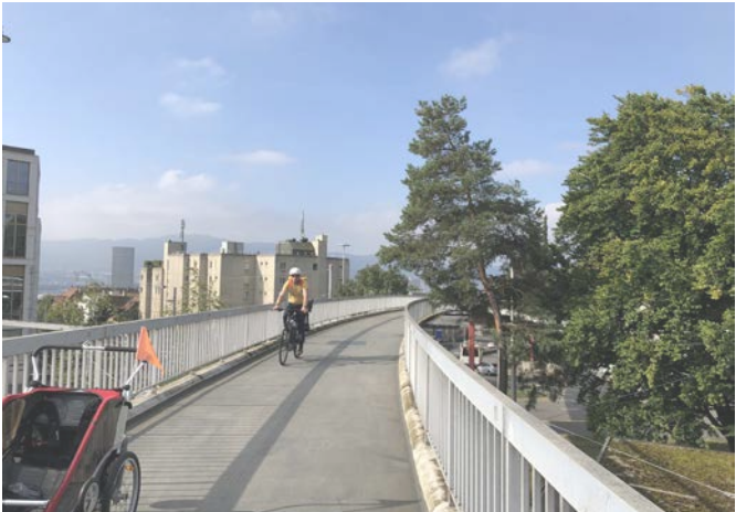
Pedestrian Bridge Buchegplatz
