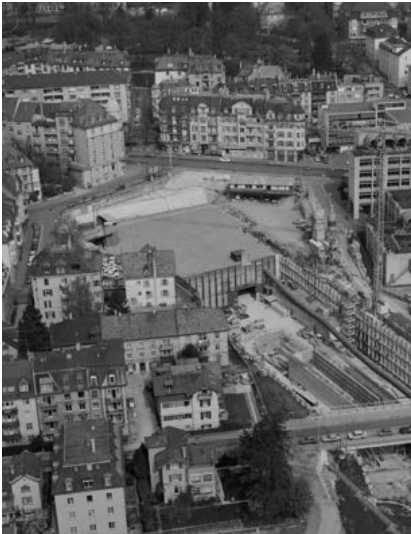
Zürich Unterstrass während Bau des Milchbucktunnel (1980-1983) (Swissair Photo AG; ETH Bibliothek)
