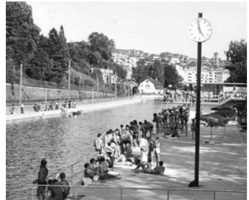
Flussbad Oberer Letten, gegenüber rechtsufrige Züribahn vor Abbruck (ETH Bibliothek)
