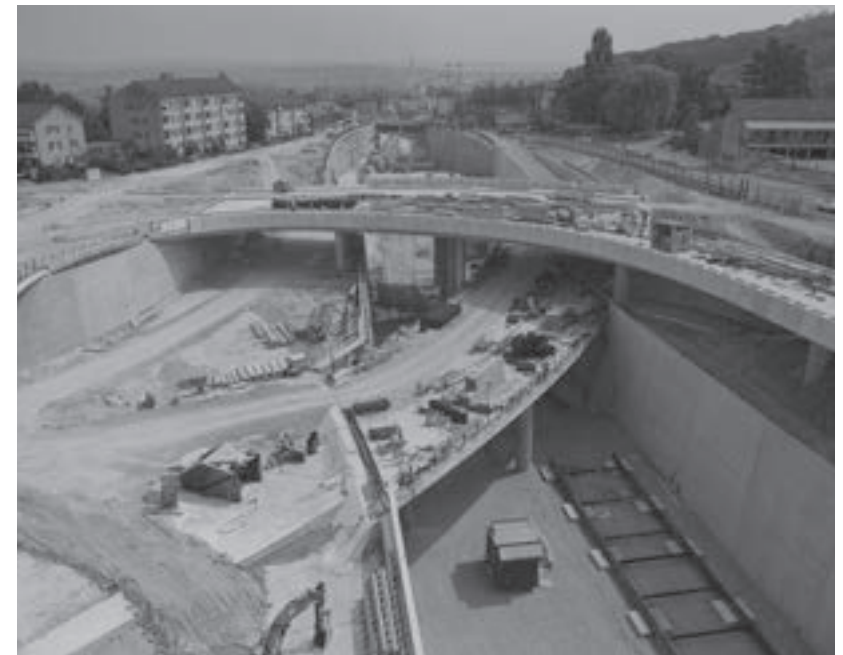
Baustelle Milchbucktunnel 1977 (Comet Photo AG, ZH; ETH Bibliothek)
