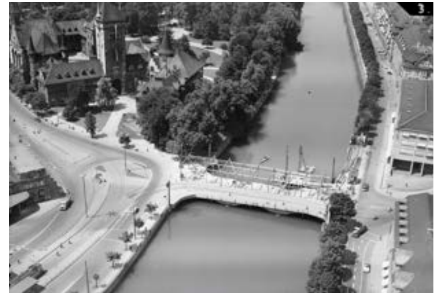
Umbau Walchebrücke 1957 (Lindroos, Björn Erik; ETH Bibliothek)
