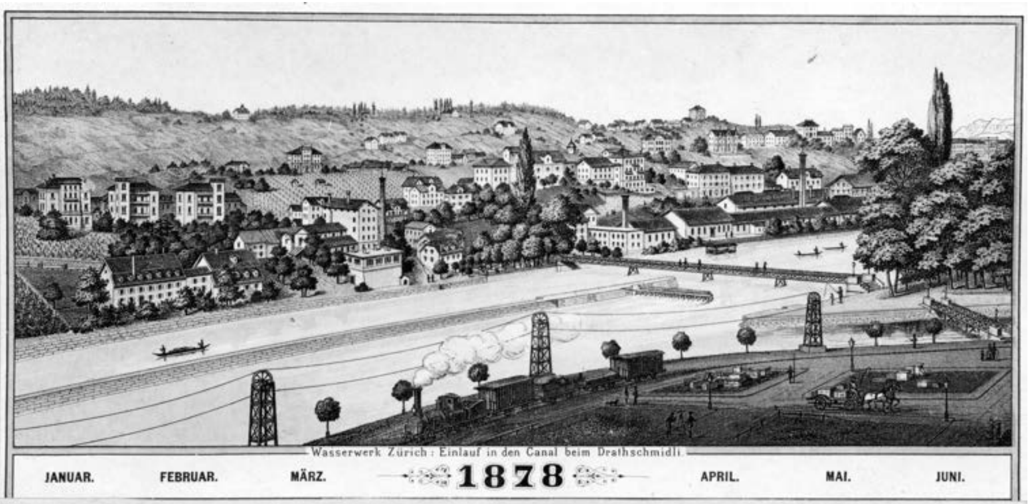
Wasserwerk Zürich: Einlauf in den Canal beim Drahtschmidli 1878 (J.J.Hofer)
