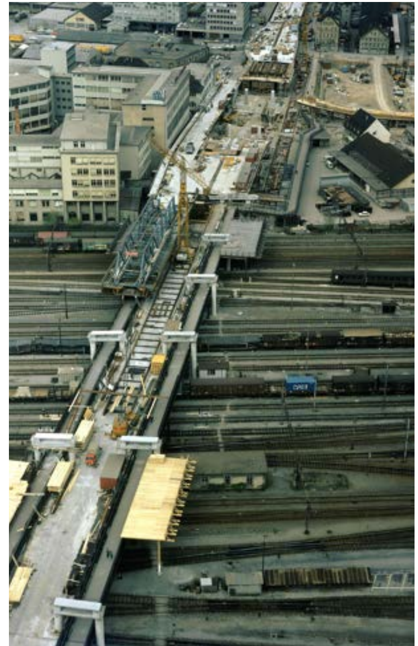
Baustelle Hardbrücke 1972 (Lindross, Björn Erik; ETH Bibliothek)
