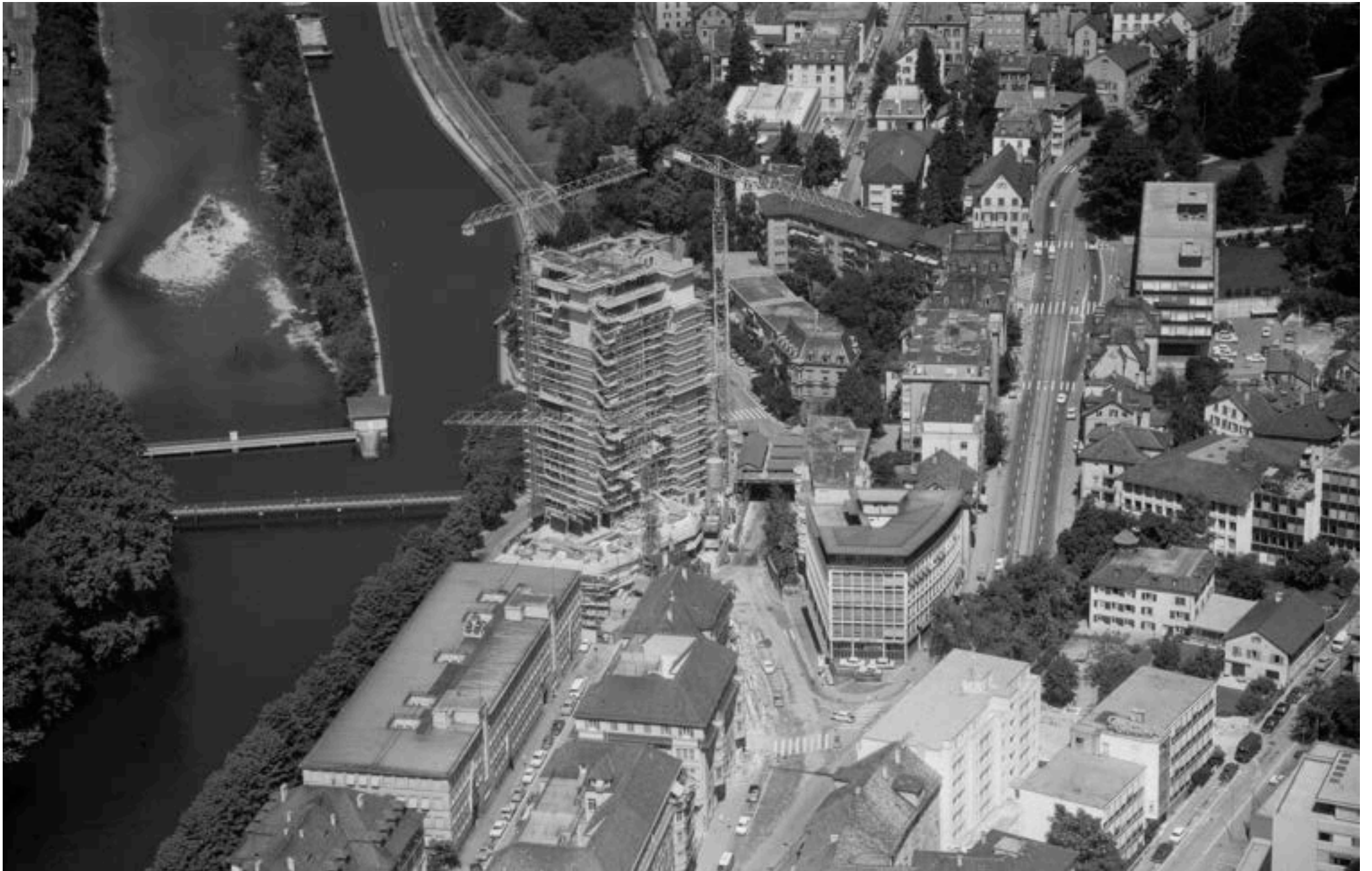
Hotel Zürich im Bau (fertiggestellt 1972) (Baugeschichtliches Archiv)
