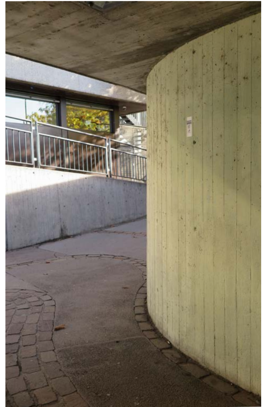
Personenunterführung zwischen Drahtschmidlisteg und Neumühlequai (erbaut 1983)
