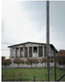
Rechenband Abwasserreignen Ofen, Wetzikon
