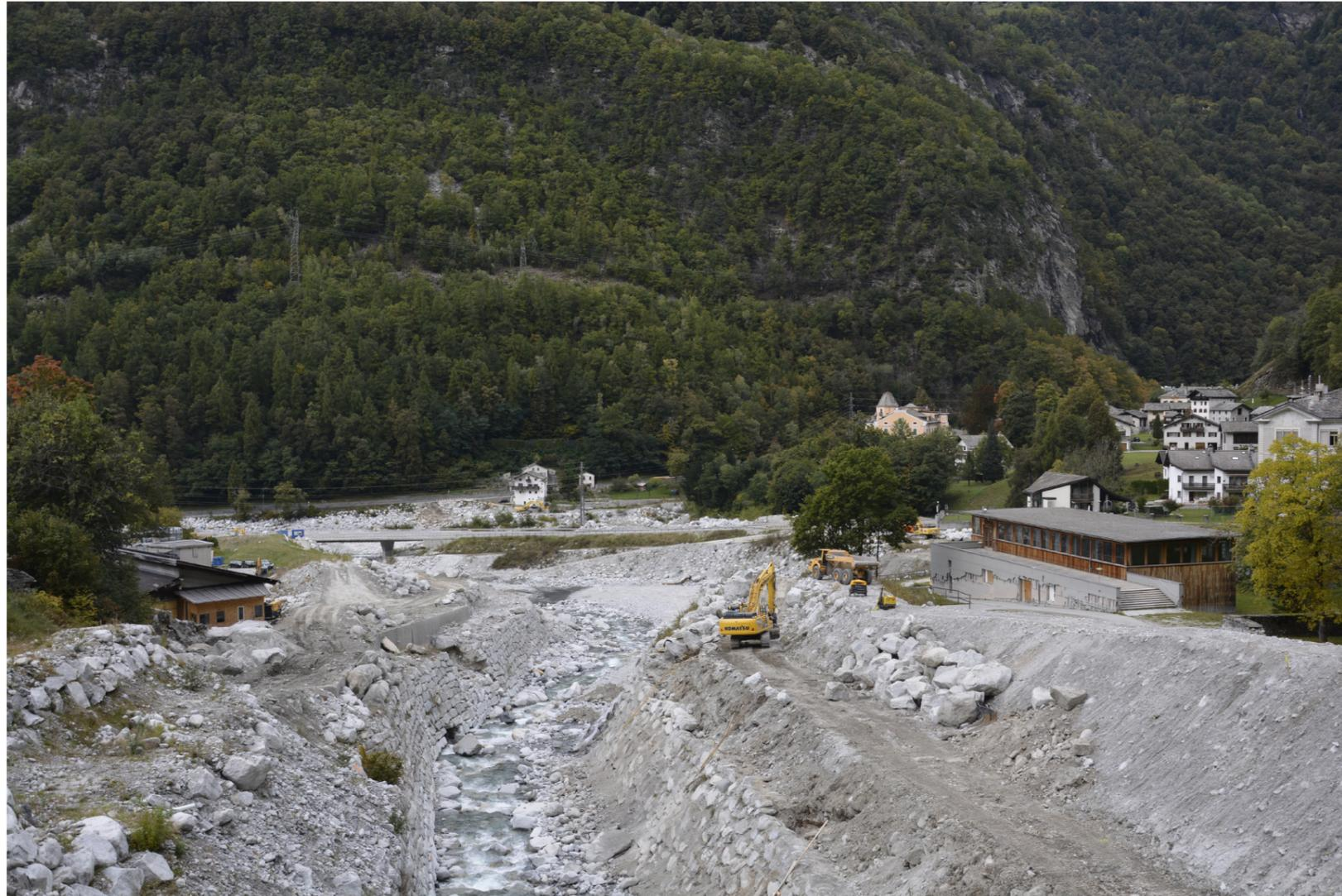
*Die vom Bergsturz in Bondo verursachten Geröllmassen werden aufgearbeitet und als Bruchstein für die Konstruktion der steinernen Sockel verwendet.*
