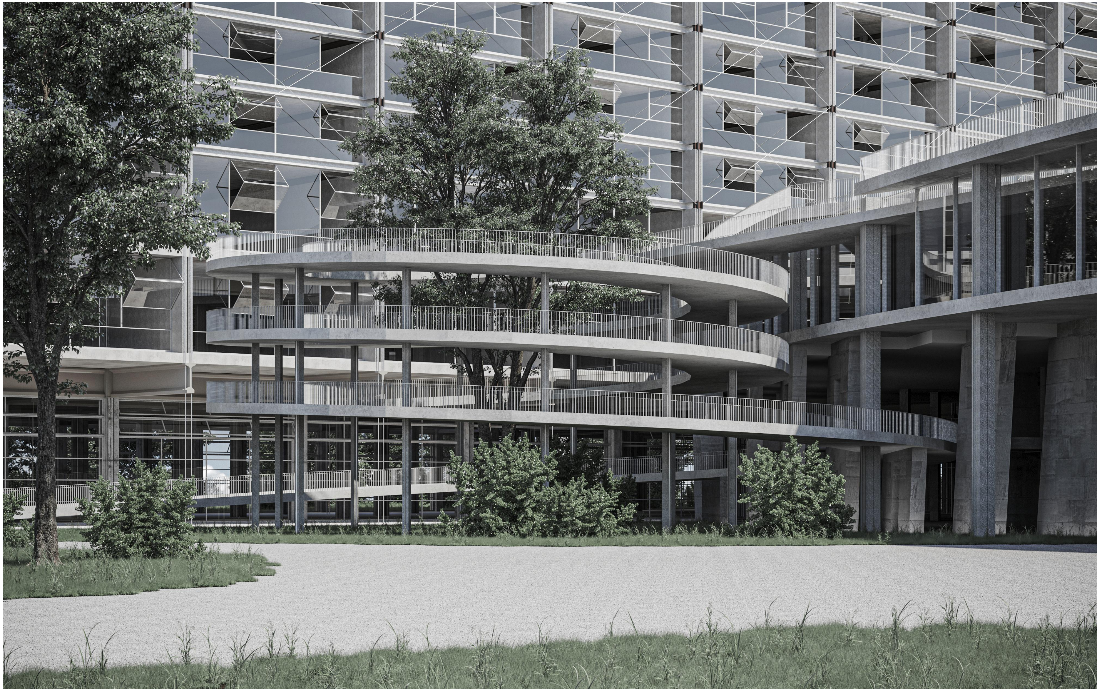
aussenraumbild von nördlicher rampe
