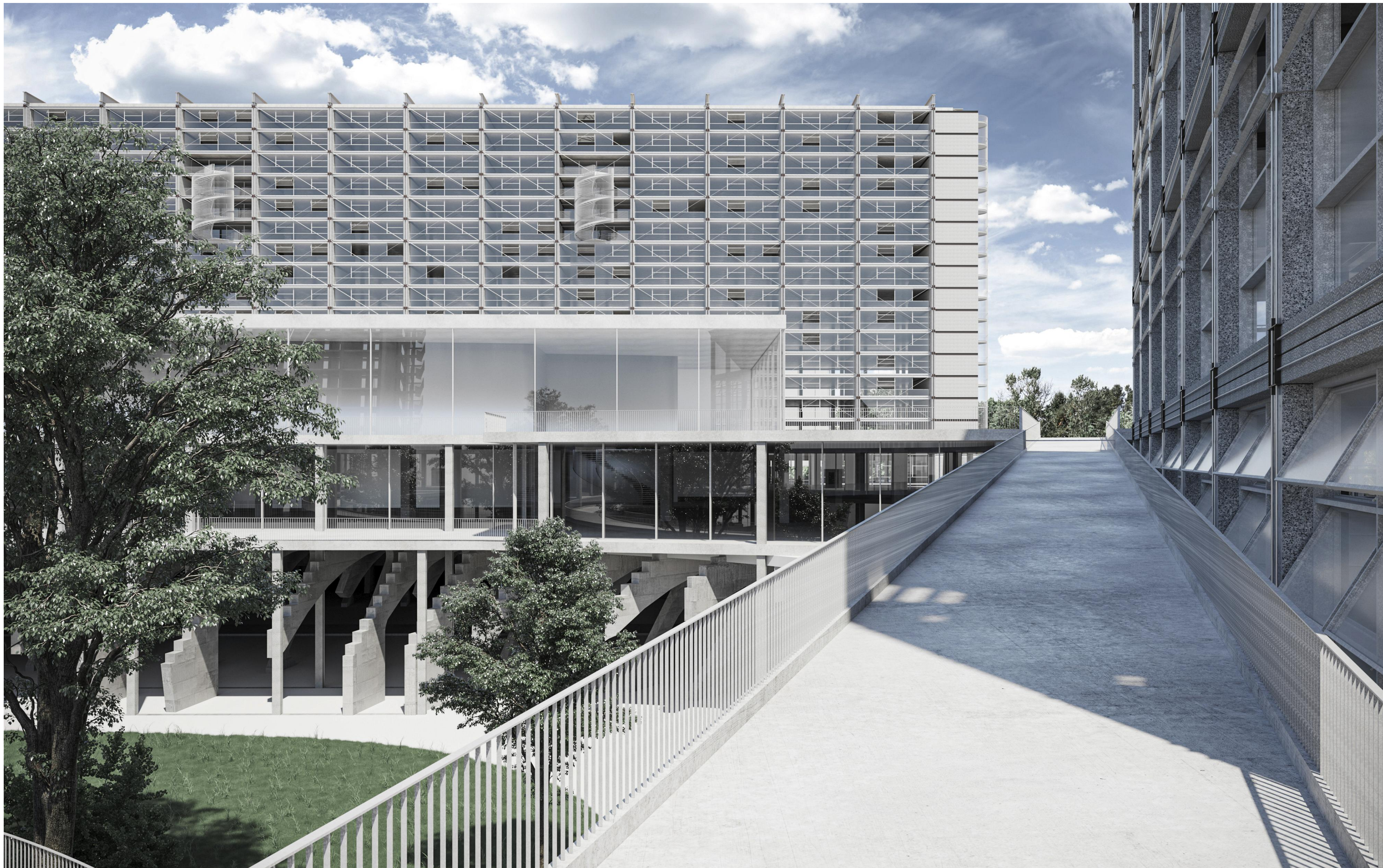
aussenraumbild auf rampe | blick nach osten
