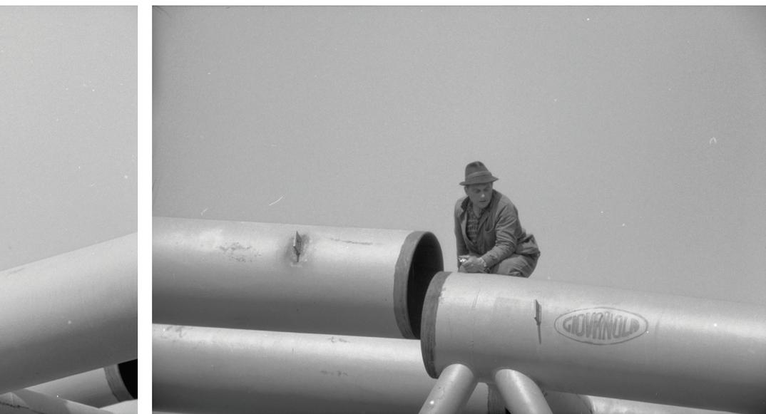
**Abb.19: Fertigstellung der Brücke für die Ölpipeline über der Rhone, 1962**
