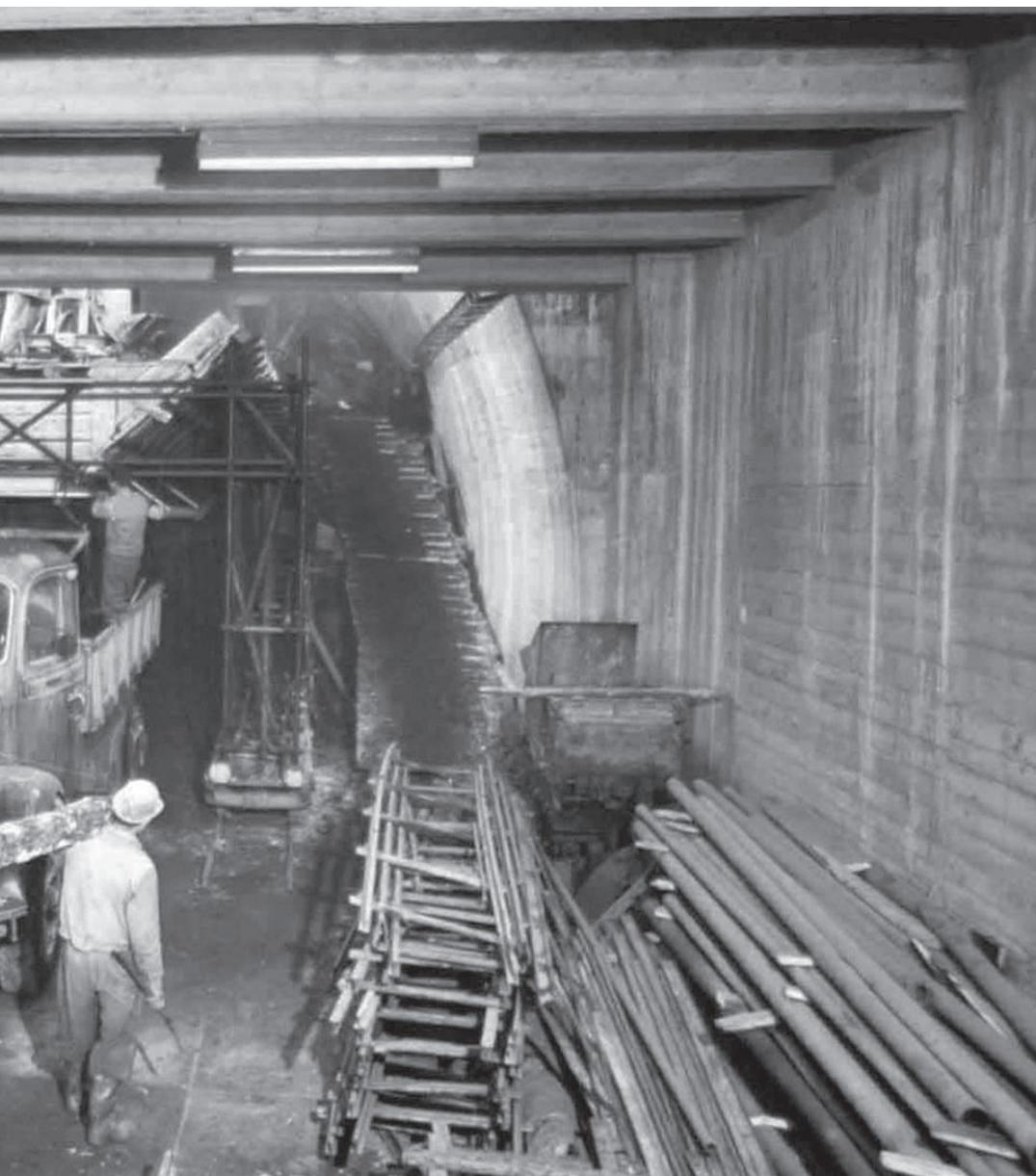
**Abb.16: Tunnelbohrung am Grossen St. Bernhard und Verlegung der Pipeline, 1962**
