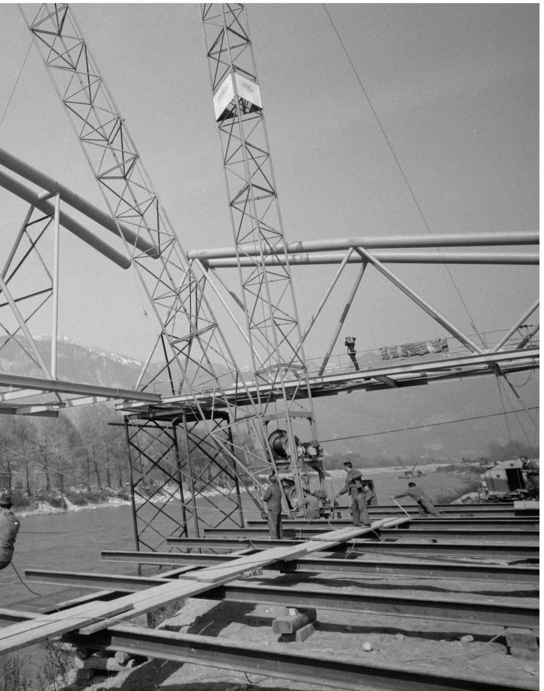
45    **Abb.18: Bau der Pipiline als Überbrückung der Rhone**
