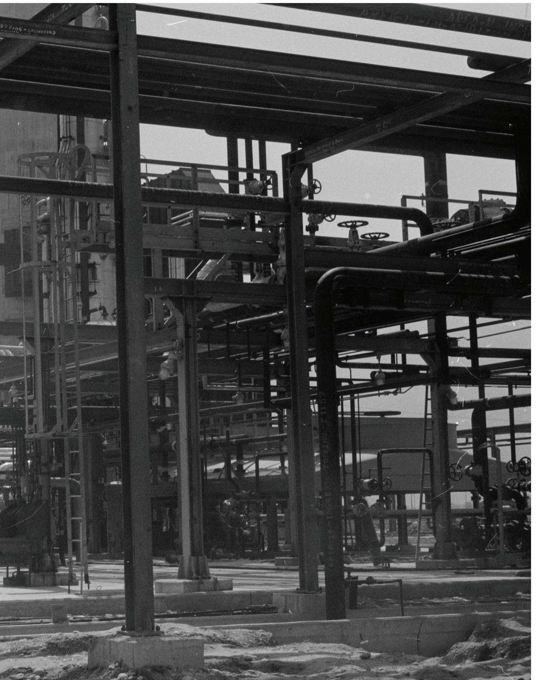
59 Abb.27: Rohrstrassen und Produktepumpen
