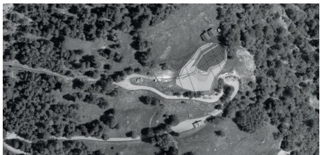
C Löschwasserbecken Gerzusteil, Baubeginn 2021
