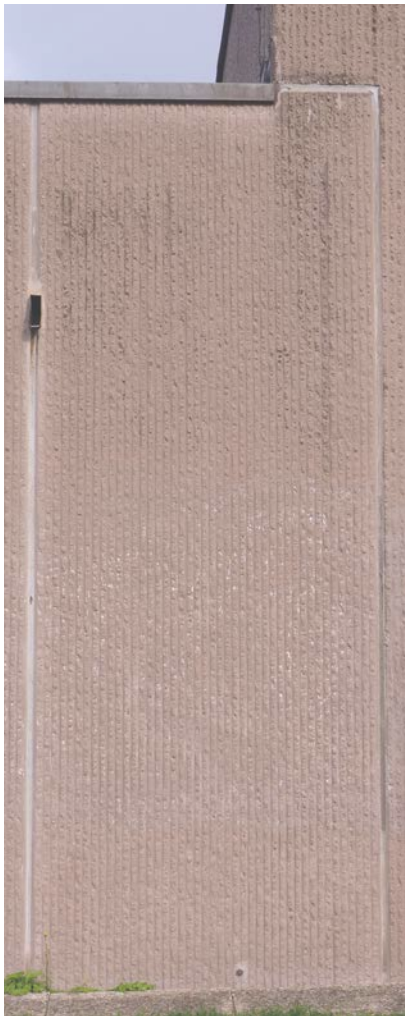
a typical 2x3m element 612 kg CO2-eq
