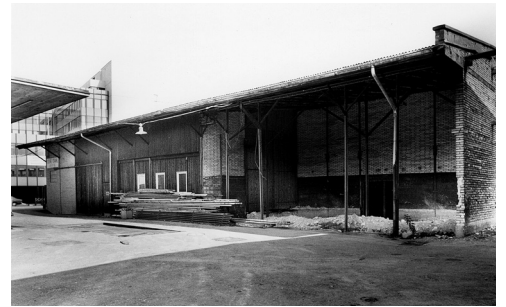
Die Geroldstrasse 11 und im Hintergrund das ZKB-Gebäude. (Quelle: Baugeschichtliches Archiv Zürich, 1976)
