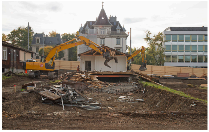
und während des Abbruchs (Bilder: Juliet Haller, AFS)
