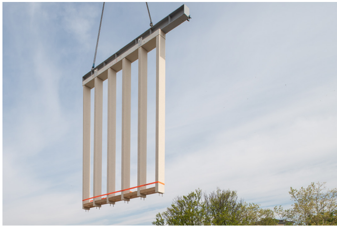
Abb. 2: Öffnen der Fassade (Bild: Juliet Haller, AfS)
