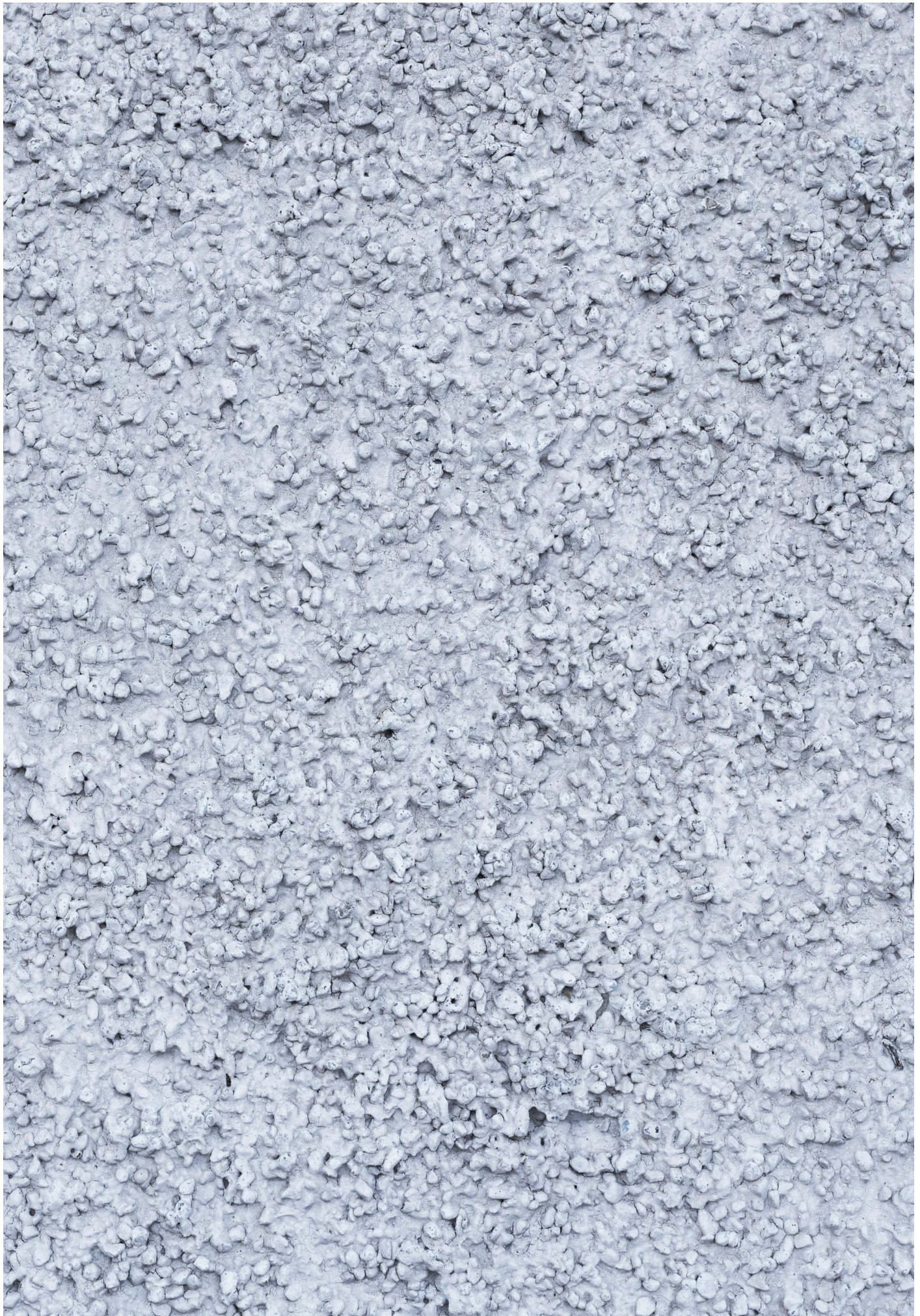
Sockelputze zur Verkleidung der neuen Dämmschicht ( Bilder: Clara Richard )
