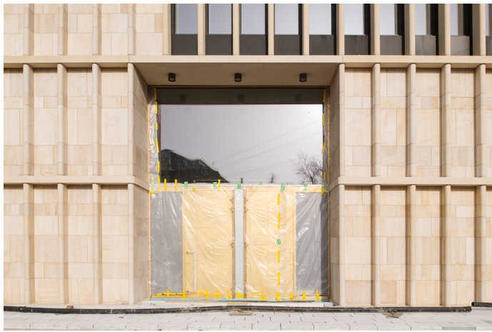
Abb. 1: Alter Eingang vor der Umnutzung (Bild: Juliet Haller, AfS)
