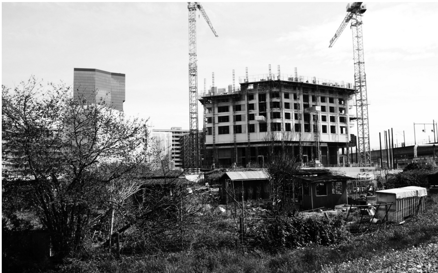
Vertikale Entwicklung Zürich Wests - das Zölly Hochhaus im Bau (2009 - 2014)
