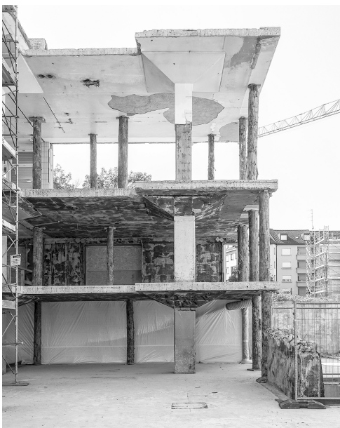
Bestandsstruktur Weinlager, Basel
