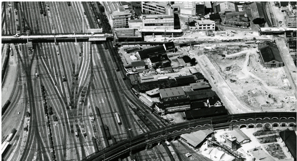
Baustellen Neue Hard und Hardbrücke, 1969 Quelle: Baugeschichtliches Archiv
