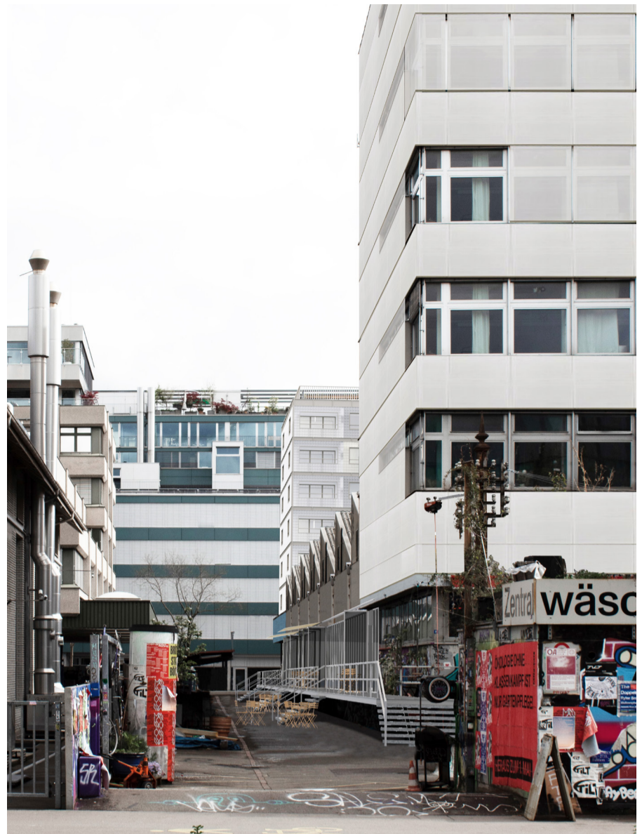
Zentralwäscherei, Georg Rohr, Monica Ciobotar
