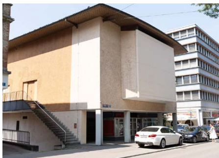
Das Kinogebäude an der Franklinstrasse steht seit 2018 definitiv unter Denkmalschutz.
