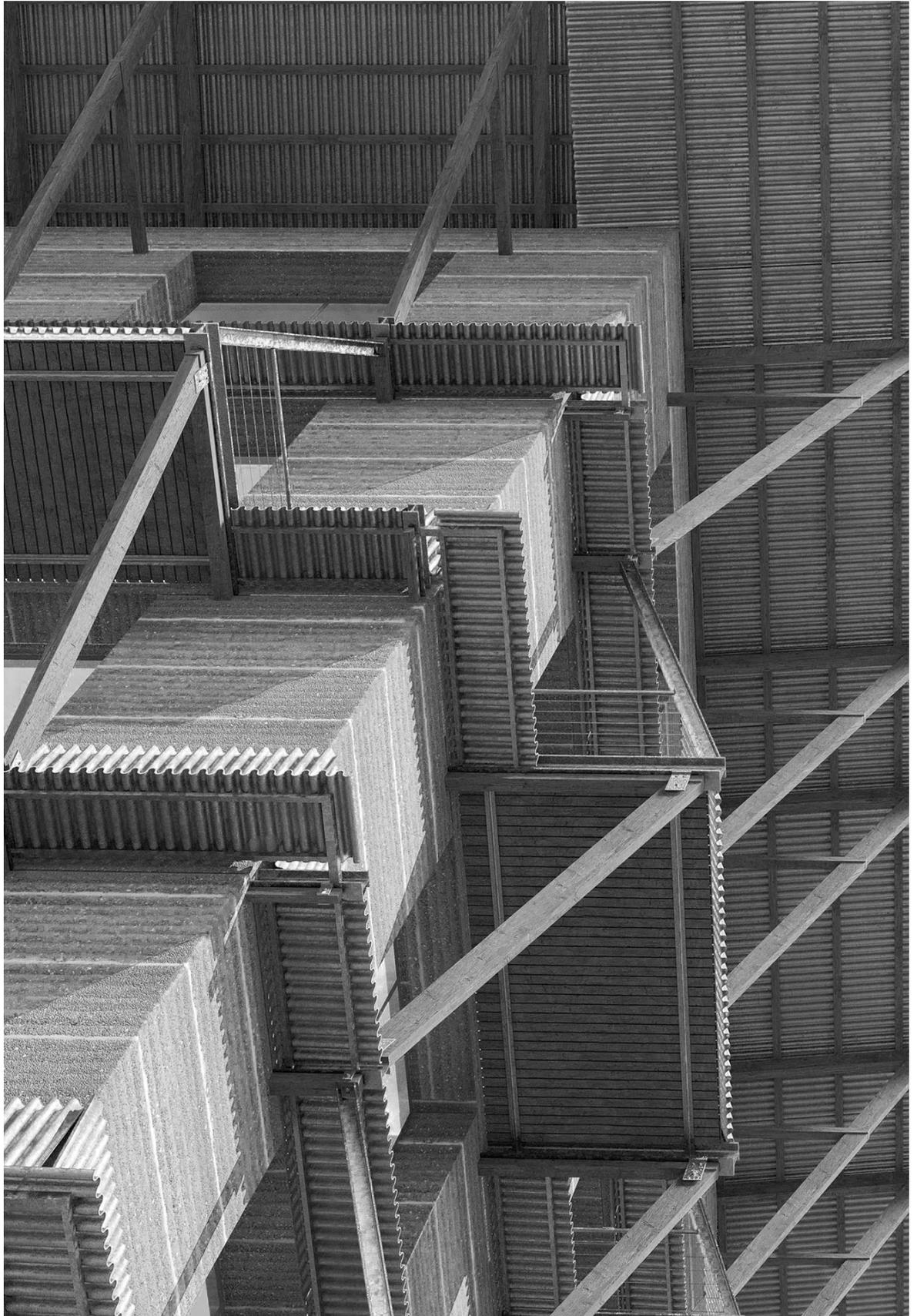
Die Materialien der abgerissenen Halle werden rezykliert. Wobei das Blech der alten Lagerhalle verwendet wird, um den Lehm und die Holzelemente der Fassade vor Regen zu schützen. Die Stahlträger werden im aussteifenden Verband wiederverwendet. Die Unterkonstruktion der Hallenfassade dient neu als Unterkonstruktion der Bleche.
