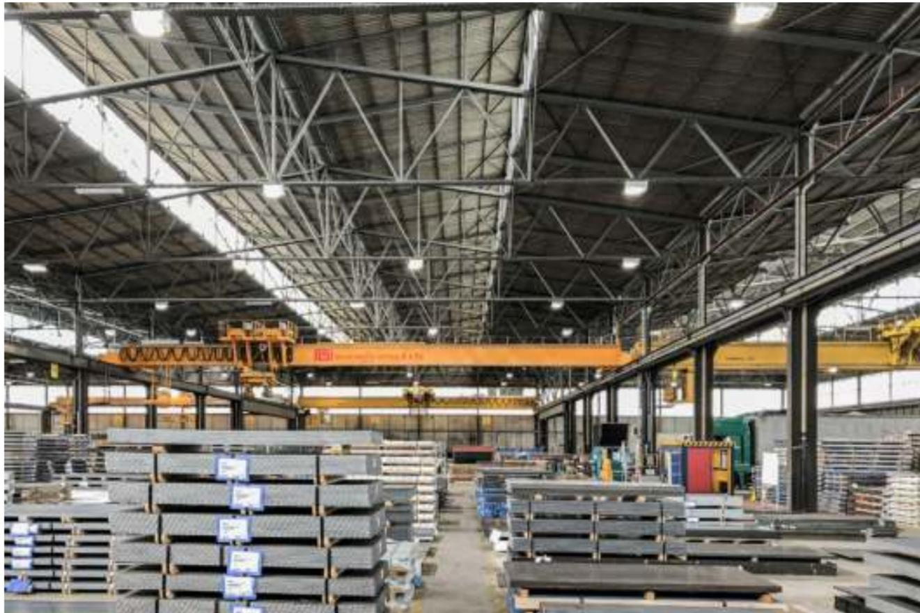
Sanierungsreife Dachkonstruktion der Lagerhalle von Debrunner Acifer
