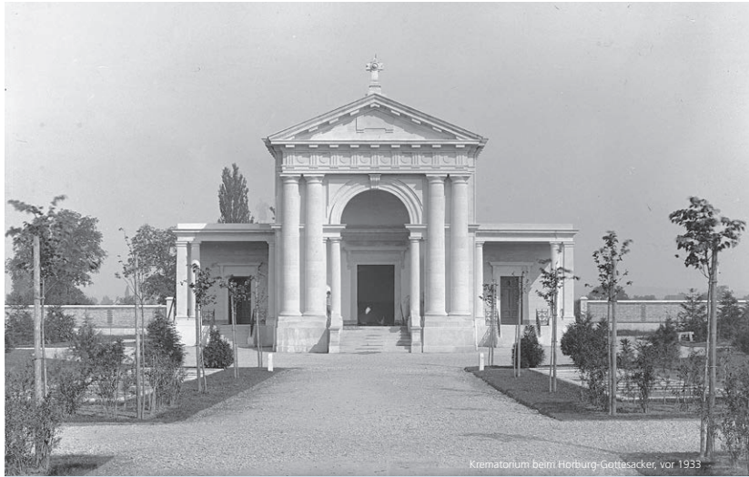
Krematorium beim Horburg-Gottesacker, vor 1933
