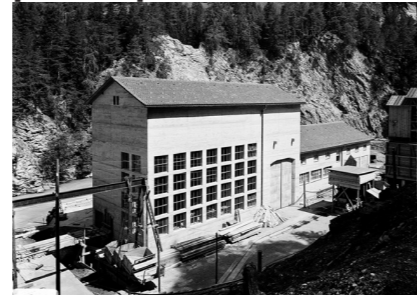
power plant Tiefencastel
