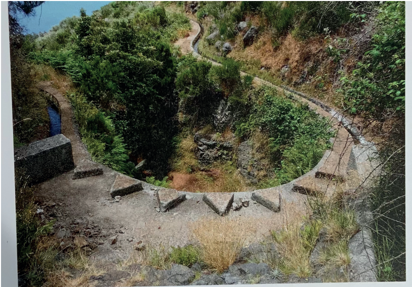
Abb. 6 | Levada do Paul mit der Einspeisung aus einem Seitenbach, der als kleiner Kanal gefasst ist (Bildvordergrund rechts). Bei Hochwasser fließt das Bachwasser
