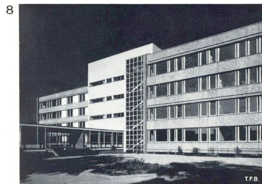
Abb. 7 Schulhaus in Deutschland mit vorgefertigten Waschbeton-Fassadenplatten. Da die Herstellung des Waschbetons doch eine verhältnismässig schwierige Arbeit darstellt, wird er oft auch auf der Baustelle oder im Betonwerk vorgefertigt.
