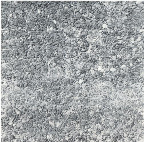
Abb. 2 Waschbeton mit normalem 30er-Rundkies mit Stellen leichter Entmischung.
