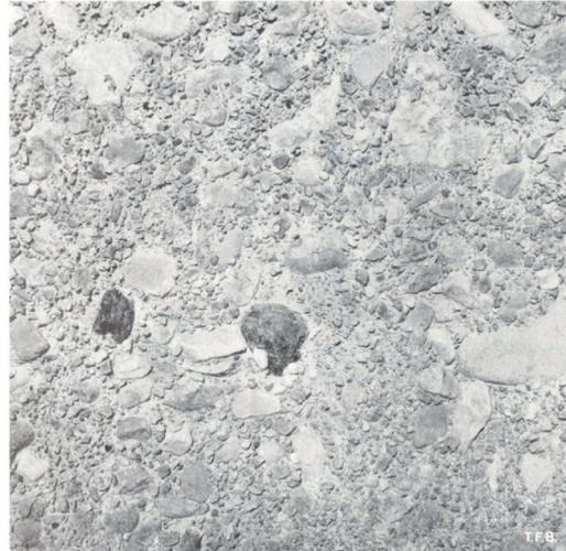
Abb. 1 Waschbeton mit charakteristischem Zuschlagsmaterial aus einer Moräne. Größtes Korn bis 100 cm.
