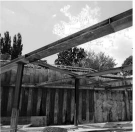
Teilabriss Tiefenmagazin und Abstützen der Baugrube
