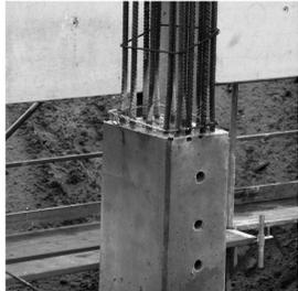
Einziehen Stützen und Bodenplatte und Aufbau Traggerüst für Deckenschalung
