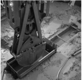
Anlegen der Leitwände und Verbau der Schlitzwände
