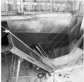
Schalung des Fallwerks und Durchbrüche zum Untergeschoss des Altbaus
