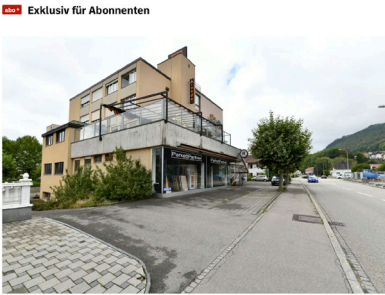
Das Hotel Rondo an Oensingens Hauptstrasse soll ab November abgerissen werden. Anstelle davon entstehen zwei Mehrfamilienhäuser und wieder ein Hotel. Bild: Bruno Kissling
