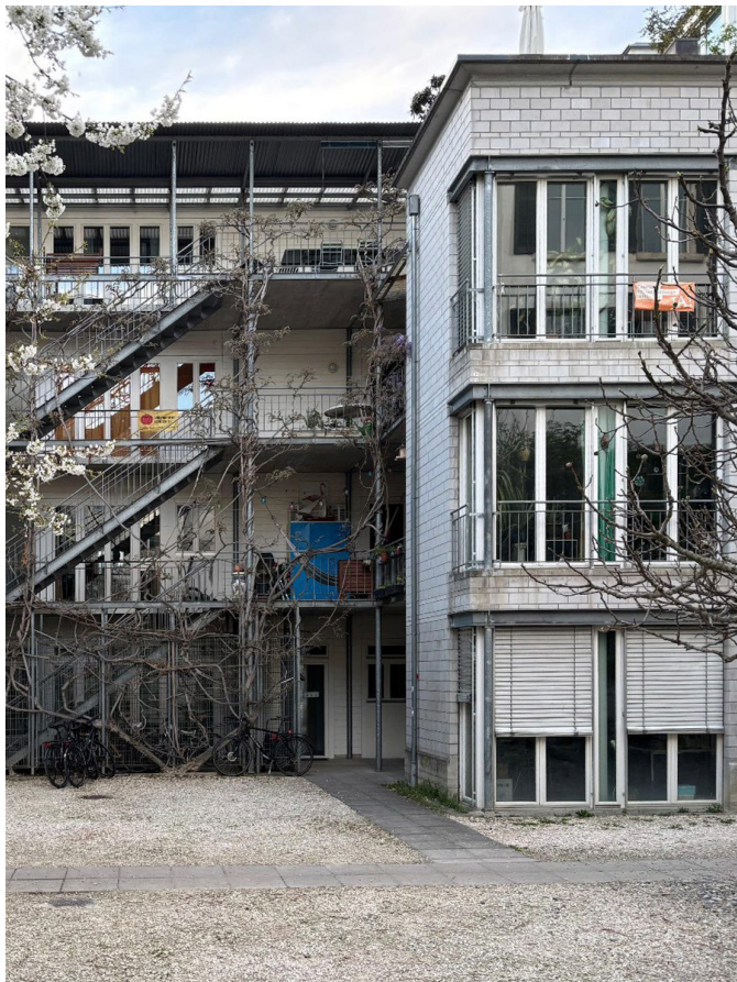
Überbauung Hellmutstrasse, Zürich A.D.P.
