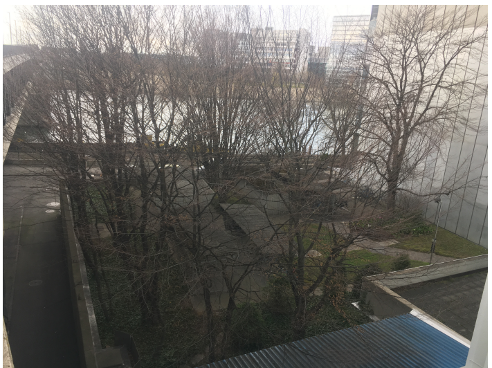
Abb. 5, Bestand zur Dreirosenbrücke
