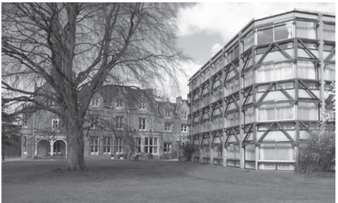
Kombination von vorgefertigten Betonpfosten und fachwerkartigem Holzgitter, Garden Building, St. Hildas College, Oxford, Peter und Alison Smithon Fotografie: Steve Cadman
