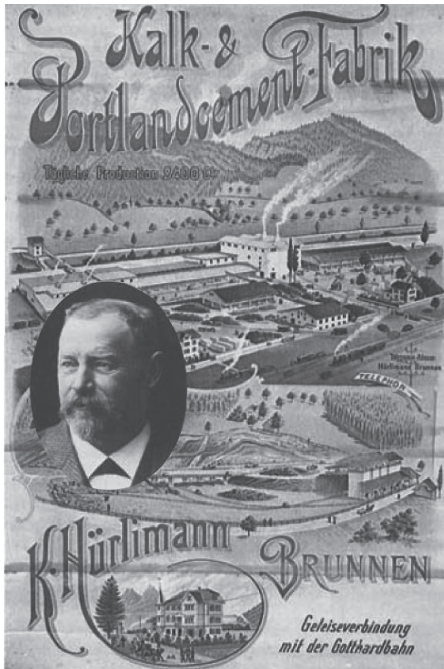
Werbepplakat der Kalk- und Portlandcementfabrik K. Hürlimann Quelle: «Masterplan Zementfabrik Brunnen-Ingenbohl», Fischer Architekten
