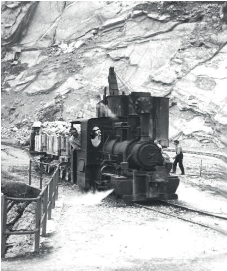
Transport der gebrannten Kalksteine vom Steinbruch in Unterschönenbuch zum Malwerk an der Muota mit der dampfbetriebenen Werkbahn Quelle: www.eingestellte-bahnen.ch
