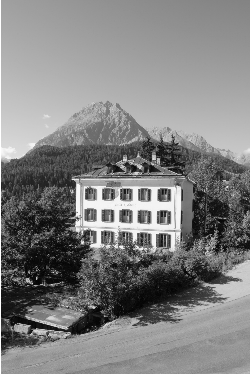
Leerstehendes Hotel Lischana in Scuol
