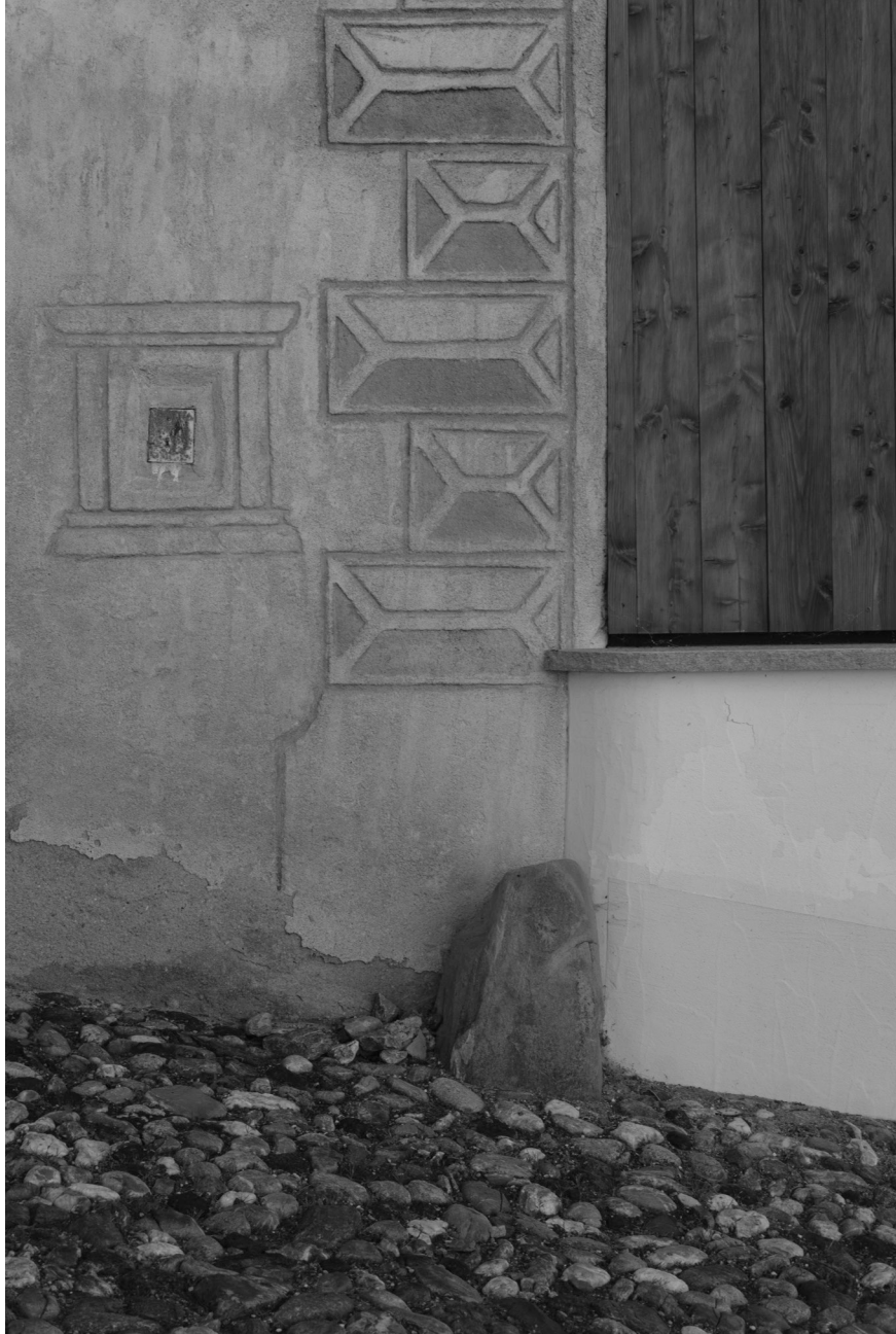
Mit Stein markierter Übergang zwischen zwei Gebäudeteilen
