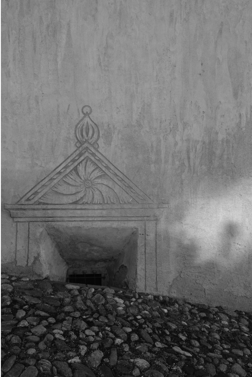
Strassenniveau vor Fensteröffnung
