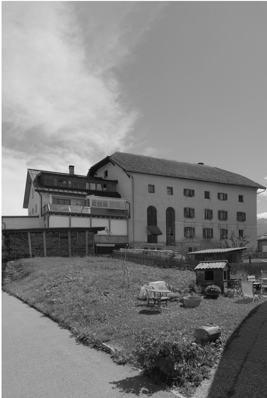
Rückwärtige Fassade des Bestandesobjektes in Ftan
